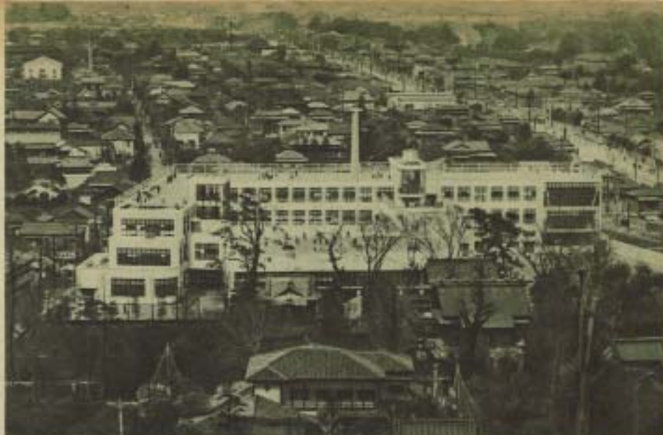
Veduta generale della Scuola Vetsuyn.
